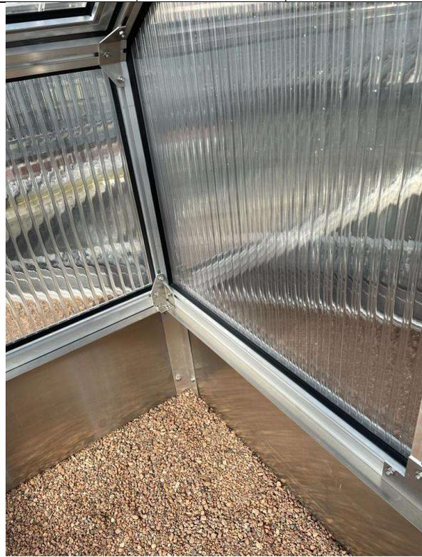
Alle 4 Bleche mit den Schrauben und Muttern mittels Eckwinkel zusammenfügen.
